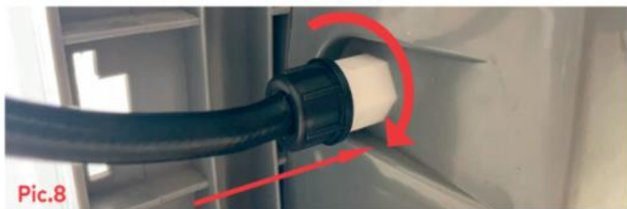
Conecta la manguera de evacuación de la bomba
